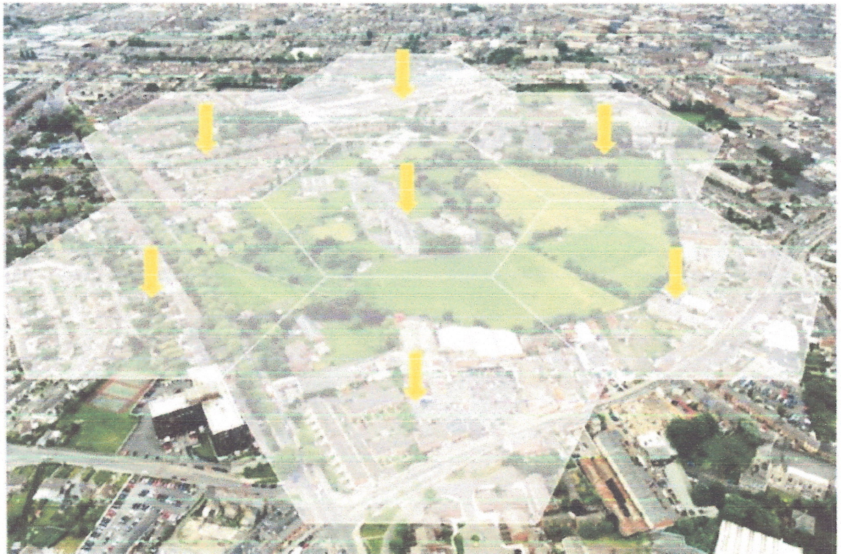
Na foto acima as setas amarelas representam as respectivas ERBs no centro da célula de cobertura
