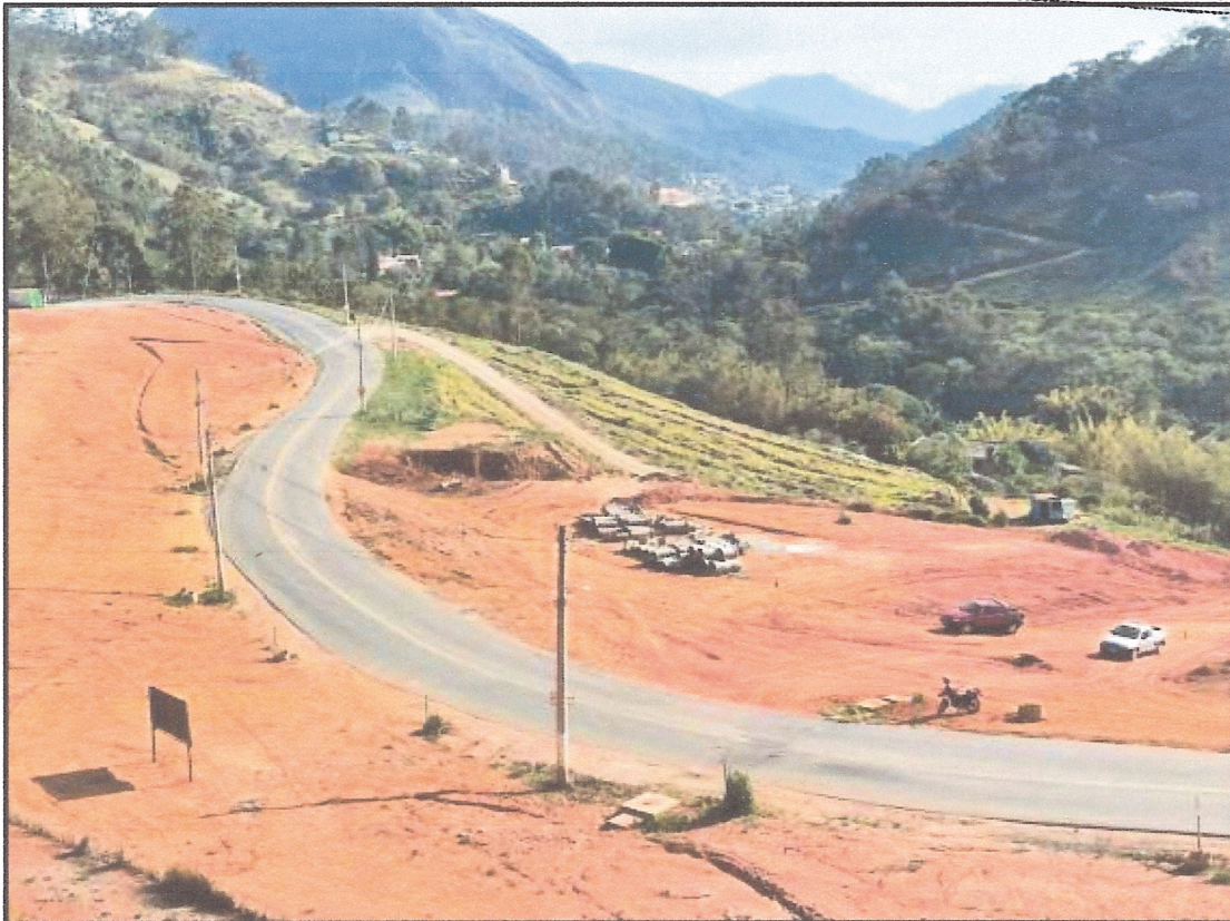
Figura 06: Rede pública de distribuição elétrica. Fonte: Sustentec, 2021.
