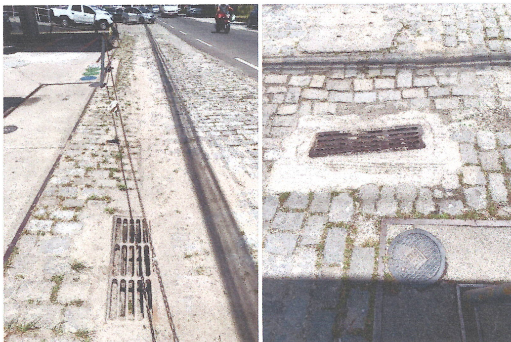
Figura 17 - Bueiros em frente ao empreendimento. Fonte: Master Ambiental.
