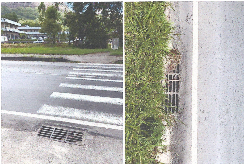
Figura 16 - Bueiros na Avenida Eng. Hans Gaiser. Fonte: Master Ambiental.
