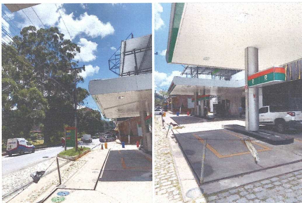
Figura 13 - Canaletas. Fonte: Master Ambiental.
