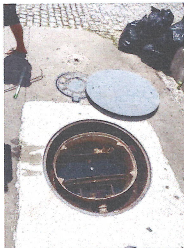
Figura 12 – Caixa separadora água e óleo. Fonte: Master Ambiental.
