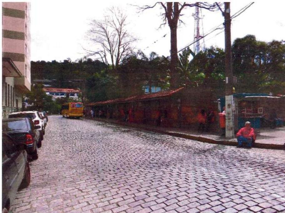
Figura 31: Ponto final da Rua Duque de Caxias. Fonte: Master Ambiental, 2017.
